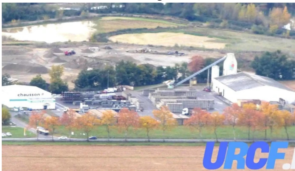
Usine chausson matériaux cazeres sur l adour
