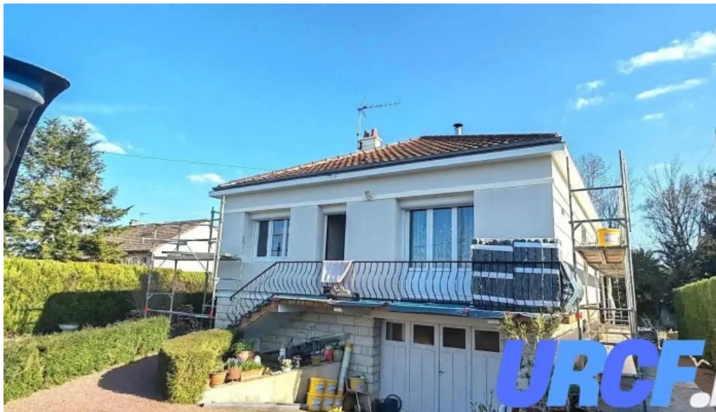
Sarl murzeau buxerolles
