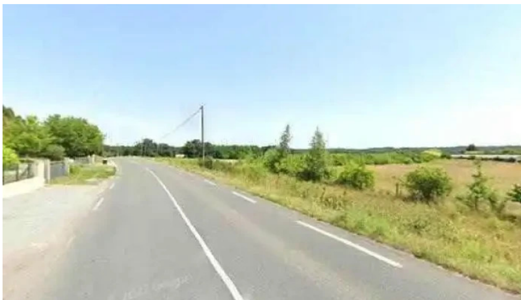
Entreprise maconnerie menard street view et 360deg
